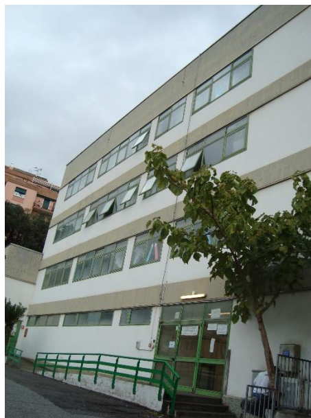
Figura 1.1 - Vista della facciata principale
