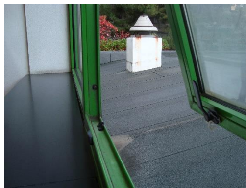
Figura 8.1 – Particolare dei serramenti esistenti
