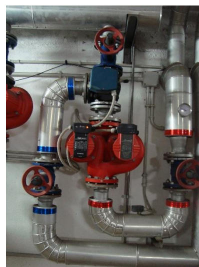
Figura 4.8 – Particolare valvola a tre vie
