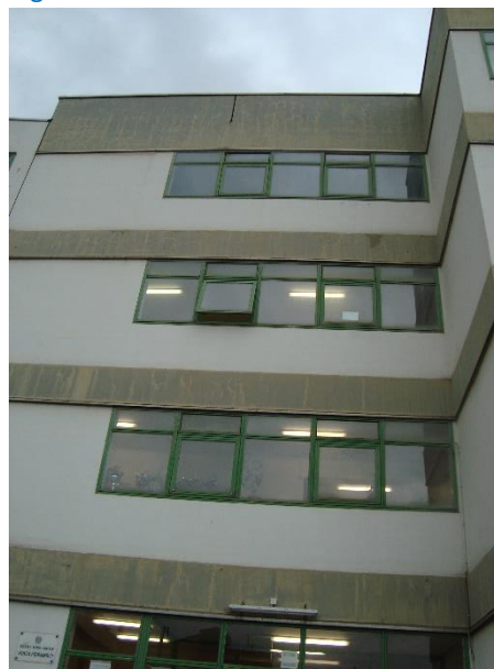
Figura 4.1 - Particolare facciata fabbricato
