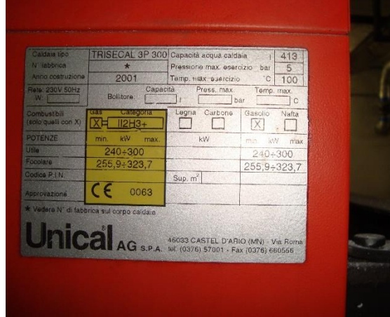
Figura 4.12 - Particolare targhetta bruciatore
