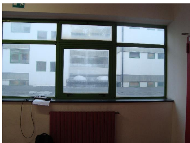
Figura 4.5 – Particolare radiatore su parete esterna
